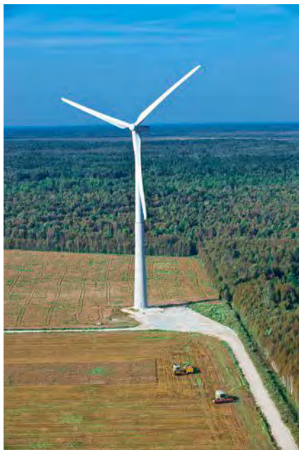
Kuvat 2-3. Periaatekuva tuulivoimalasta ja kuva teräsbetonirakenteisesta tuulivoimalasta (Lähde: WinWind Oy).
